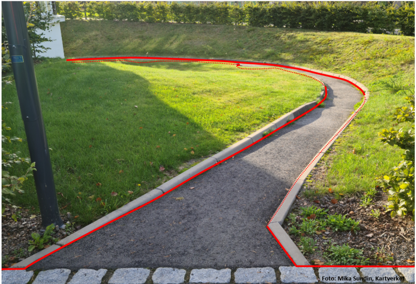
Figur 35. Eksempel på registrering av gangveger med objekttype Vegdekkekant (tegnet med rød strek), de stiplede linjene i bildet viser kun at vegdekkekanten er skjult i bildet (bak kantsteinen)
