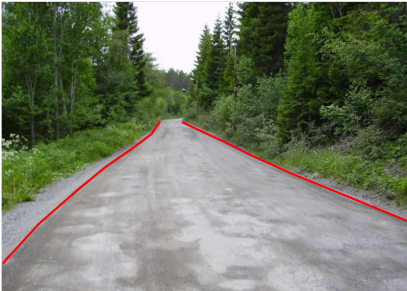
Figur 39. Eksempel på registrering av Vegdekkekant for grusveg
