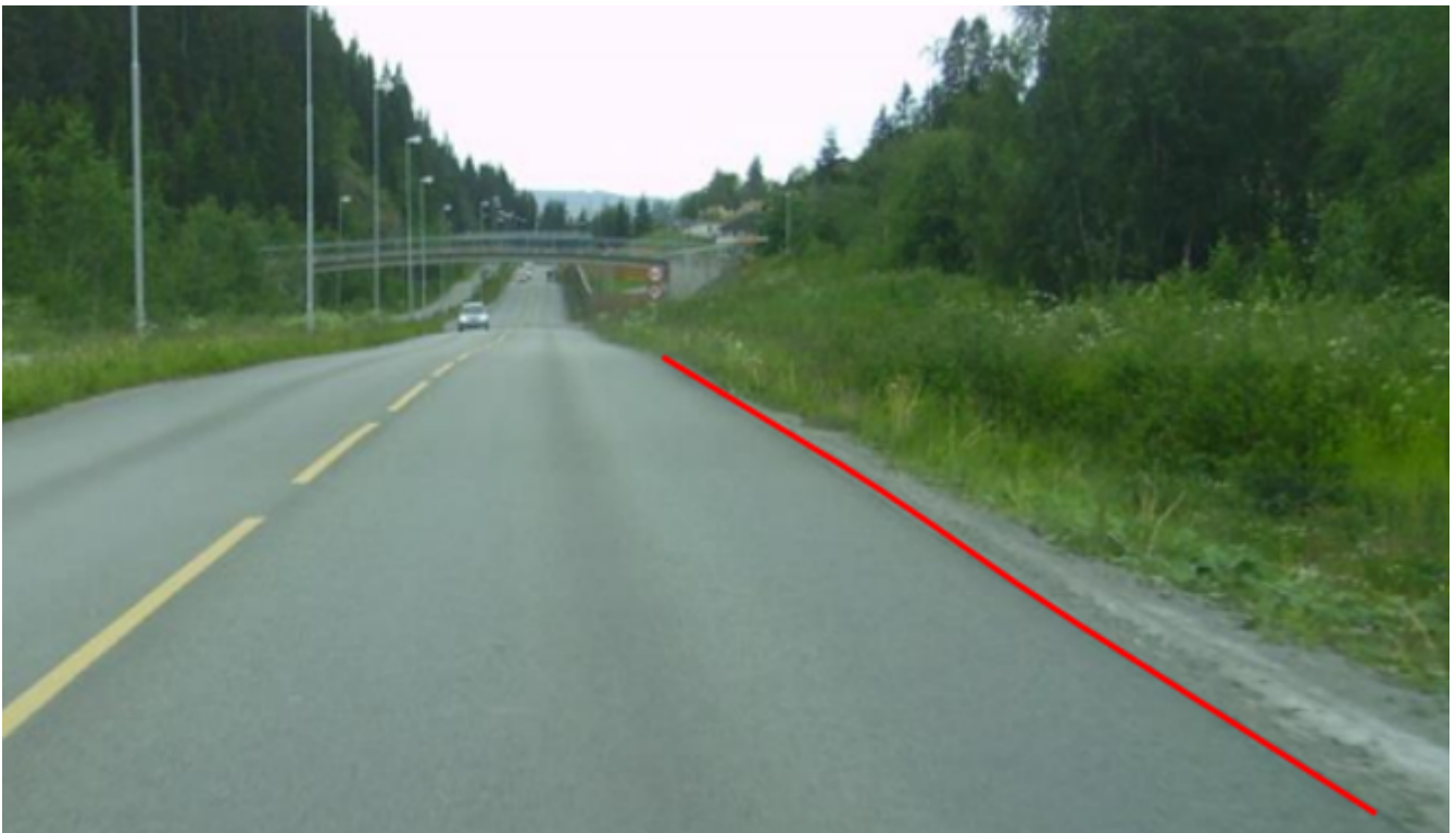
Figur 38. Eksempel på registrering av Vegdekkekanthorizont (asfaltkanten registreres – rød linje)
